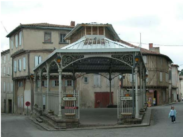
Belpech. Une halle du XIX ème qui marque de manière remarquable une intersection.
