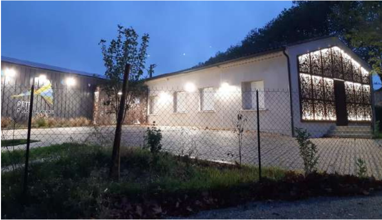
Les éclairages initiaux ont été réduits et la programmation adaptée
