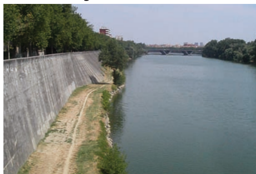
Toulouse, les digues de la Garonne
