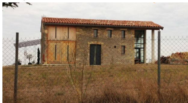
Les Casses, rénovation d'un bâti ancien
