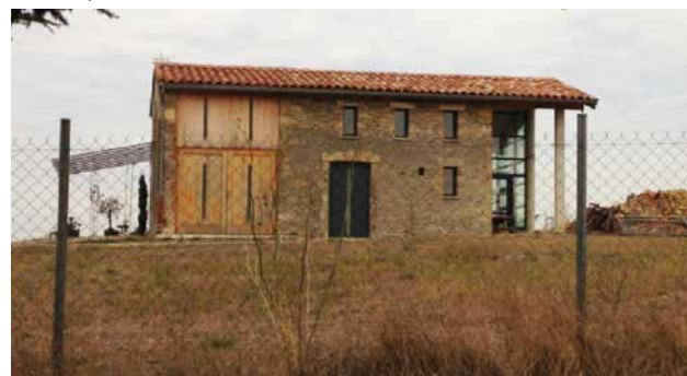
Les Casses, rénovation d'un bâti ancien
