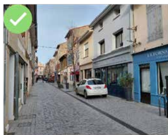
Revel - rue requalifiée et végétalisée
