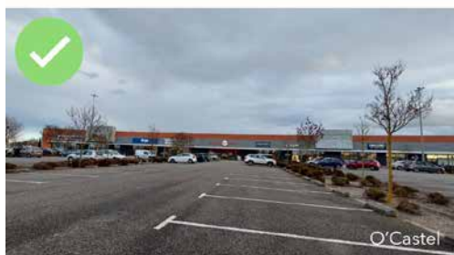
Grand parking mutualisé et intégration architecturale homogène
