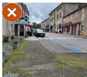
Fanjeaux - langage routier et cheminement dégradé
