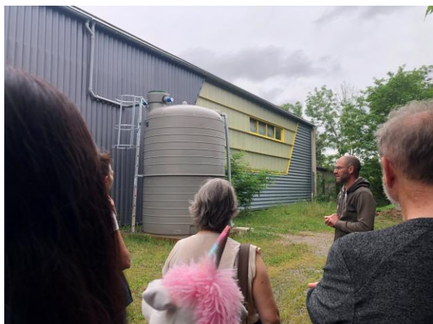
Stockage d'eau de pluie pour les services techniques communaux de Saint Benoît de Carmaux – Climat Tour du 2 juin 2025
